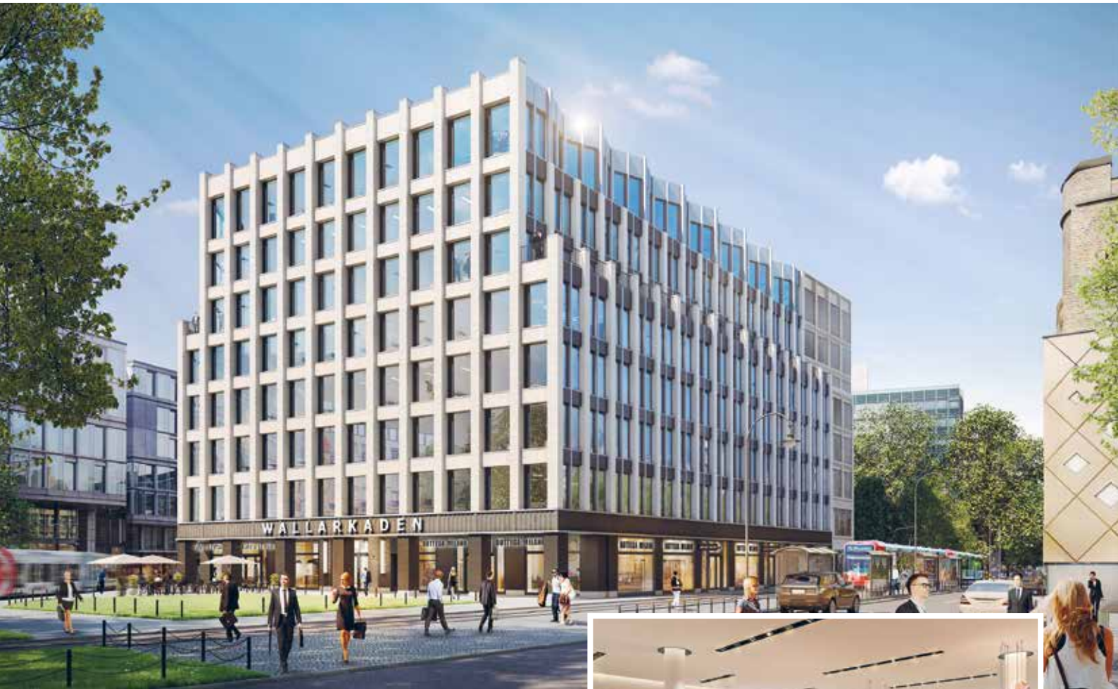
Das Anlageobjekt steht in direkter Nachbarschaft zur Hahnenorburg, diese wurde im 13. Jahrhundert erbaut.
